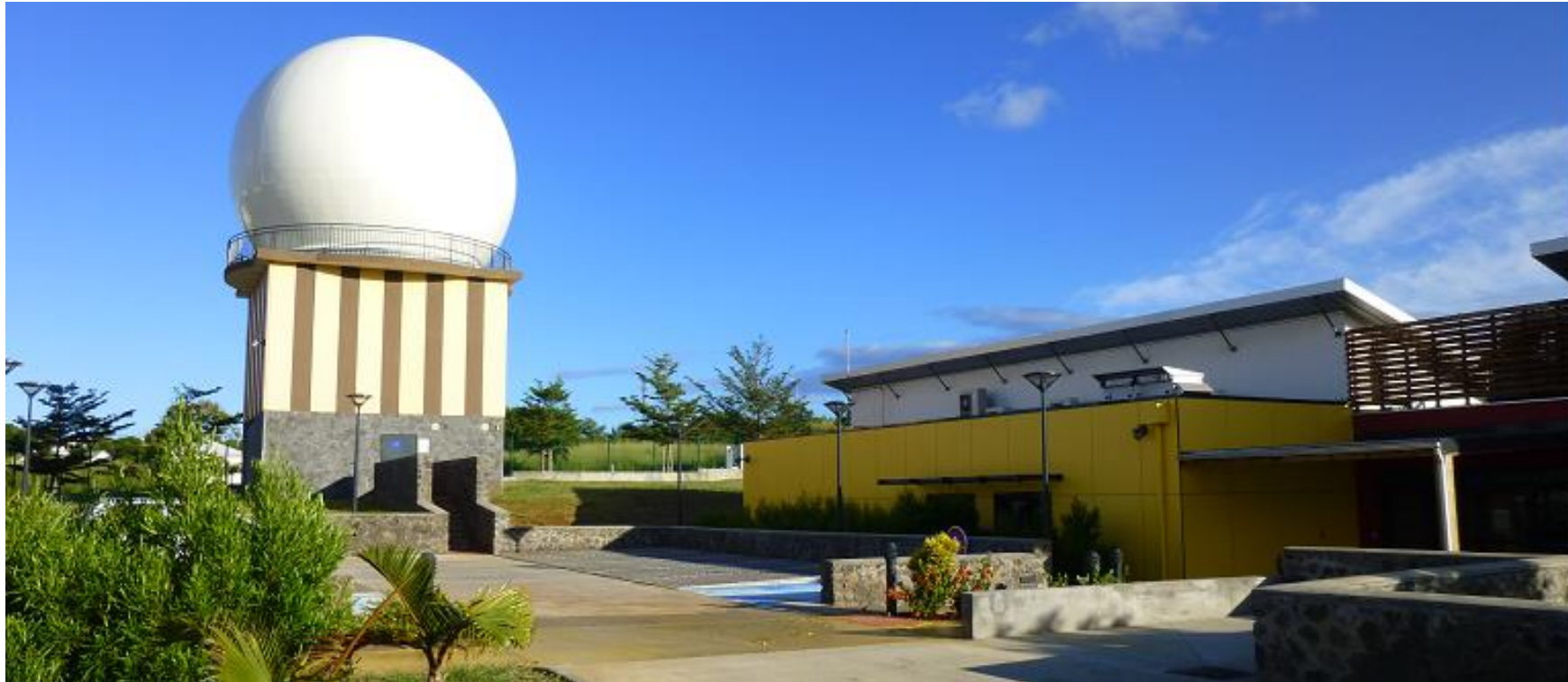
Figure 2: Vue de l'antenne sous radôme et du bâtiment technique
